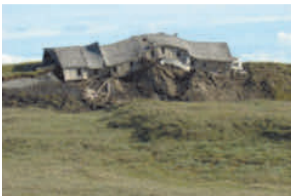
Рис. 2.8.9. Здание воинской части, разрушенное из-за неравномерного пучения и просадок.
