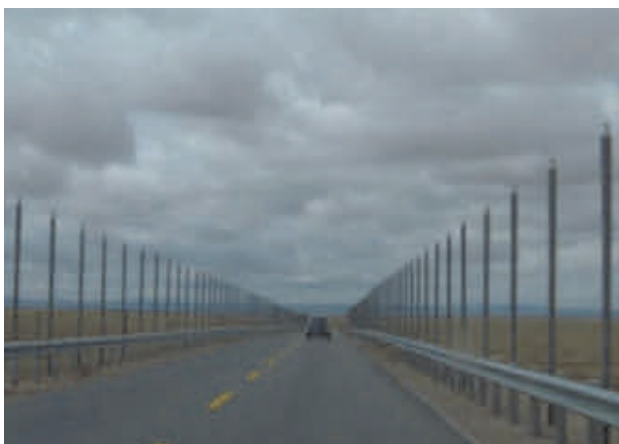
Рис. 2.8.13. Дорога с замораживающими термосифонами.
