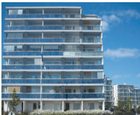
Рис. 3.2.12. Виики – квартал зданий с низкими энергозатратами в Хельсинки (Финляндия). В фасад здания встроены панели, аккумулирующие солнечную энергию.
