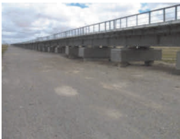
Рис. 2.8.14. Дорога на специальных заглублённых в землю опорах.
